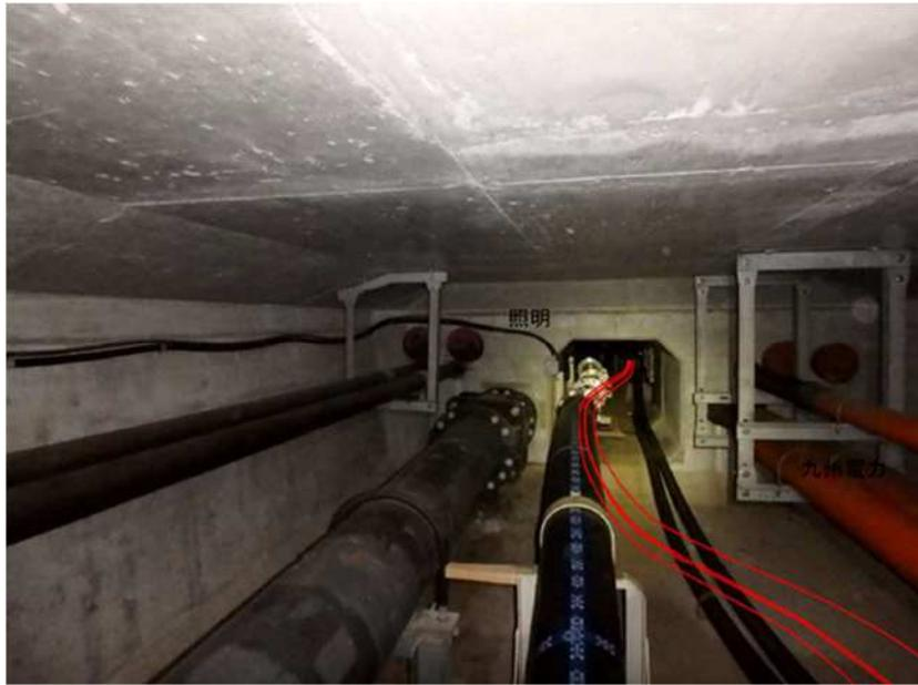
图 2.2.5-6 (1) 送電線橋梁内部共架例
