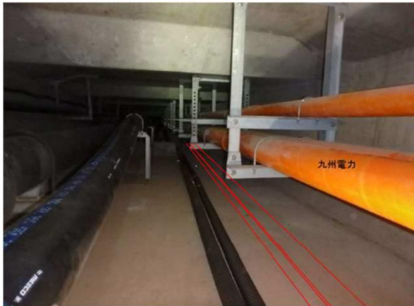
图 2.2.5-6 (2) 送電線橋梁内部共架例
