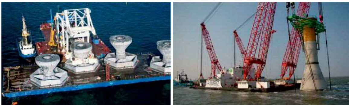
図 2.2.4-4 基礎部の運搬と設置のイメージ
