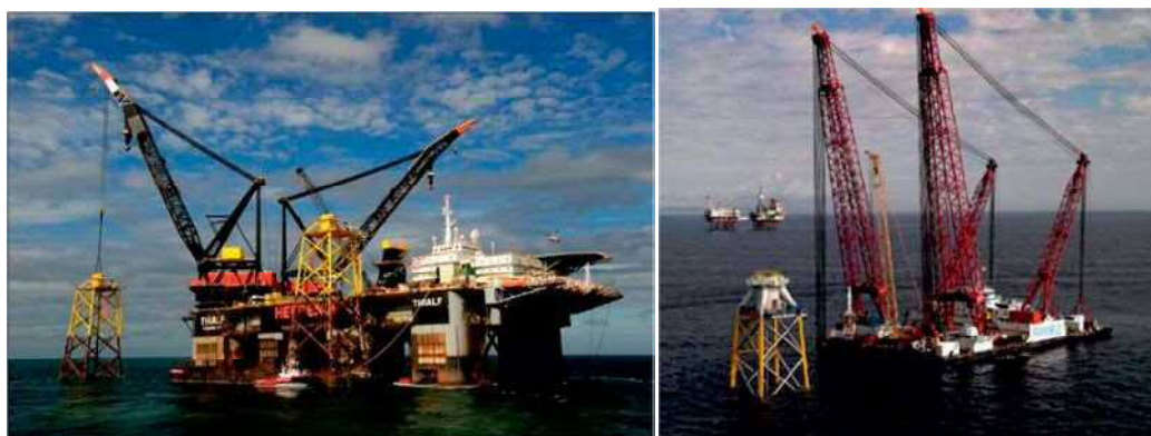
図 2. 2. 4-9 ジャケットの吊り上げのイメージ
