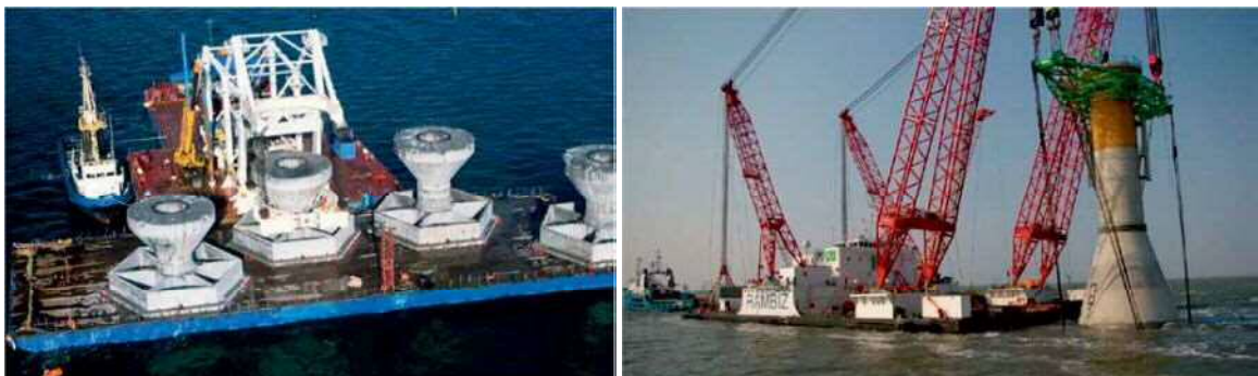
図 2.2.4-4 基礎部の運搬と設置のイメージ
